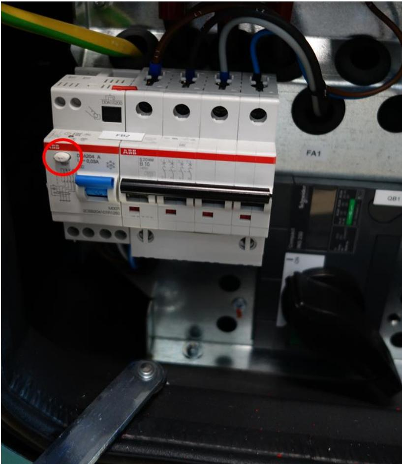
**Abbildung 101:** Funktionsprüfung des Fehlerstrom-Schutzschalters
