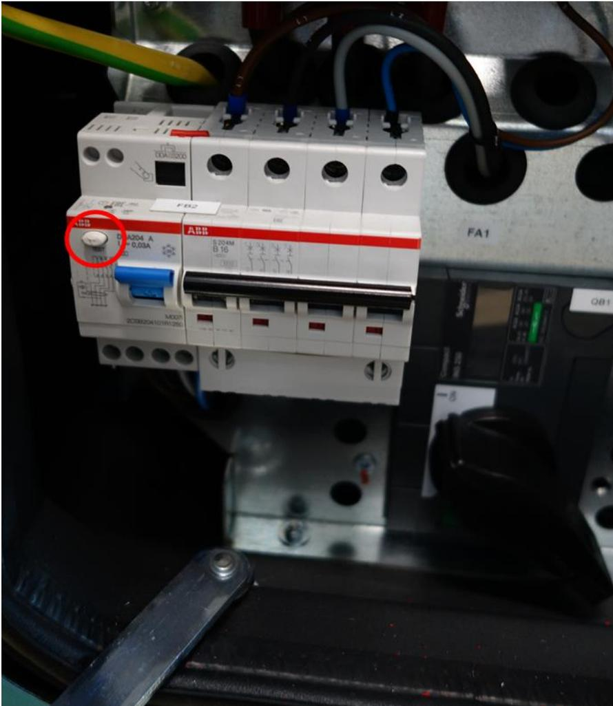
Abbildung 77: Funktionsprüfung des Fehlerstrom-Schutzschalters
