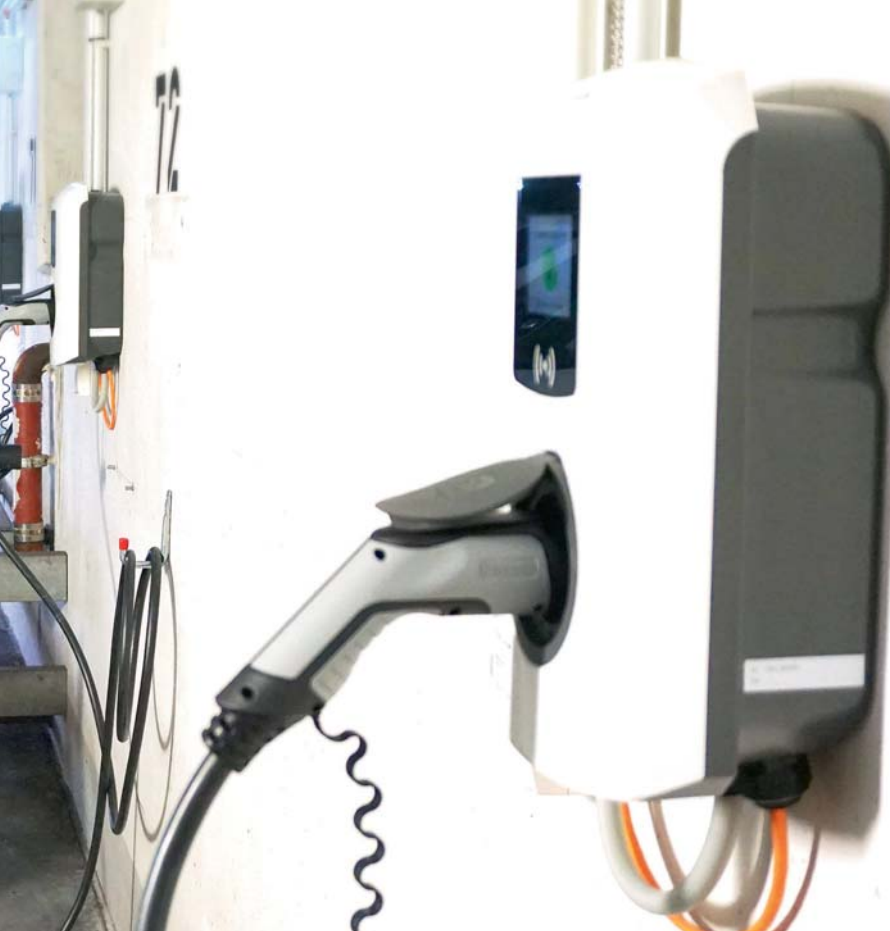
Die kleine Flotte von E-Fahrzeugen lädt zentral, was von den intelligenten Wallboxen gemanagt wird
